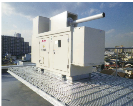
発電機更新工事
