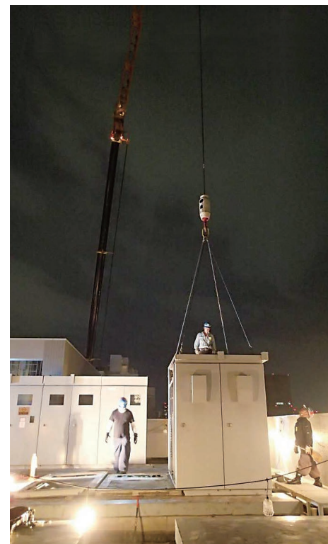
受変電設備更新工事
