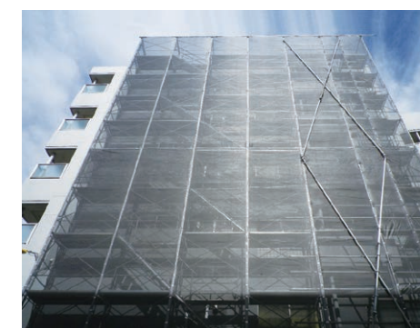
社宅 外装工事
