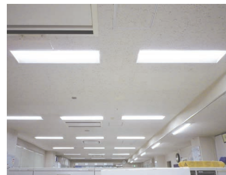
照明LED化工事
