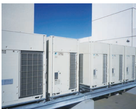
空調設備更新工事
