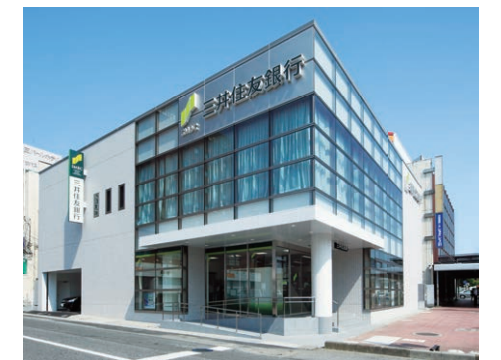
銀行支店 内装・設備工事
